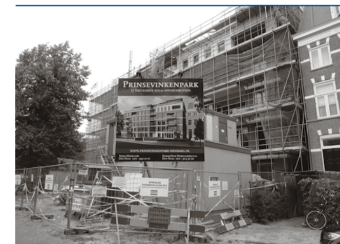
De werkzaamheden aan het Prinsevinkepark zijn weer hervat. Er is een nieuwe aannemer (van Omme&deGroot), die blijkbaar alle retentierchouders tevreden heeft weten te stellen.
